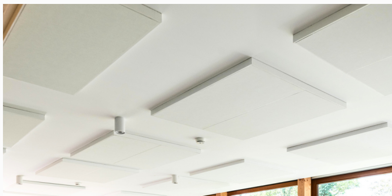
Montage au plafond
